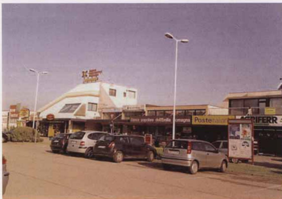
Fig. 8 - Comune di Coriano, Cerasolo-Ausa: polo commerciale.
